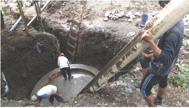
Bau der Grube für die Zisterne mit Abwasserkanal
